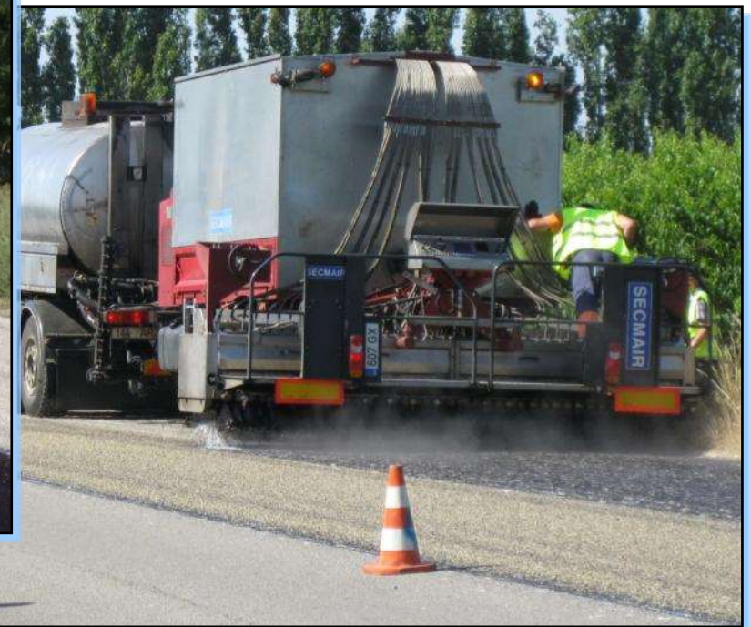
Fasi di stesa del bitume "armato"
