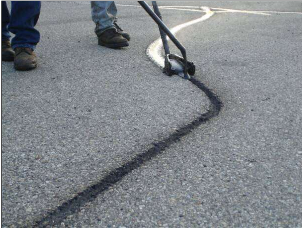
Sigillatura con routing
