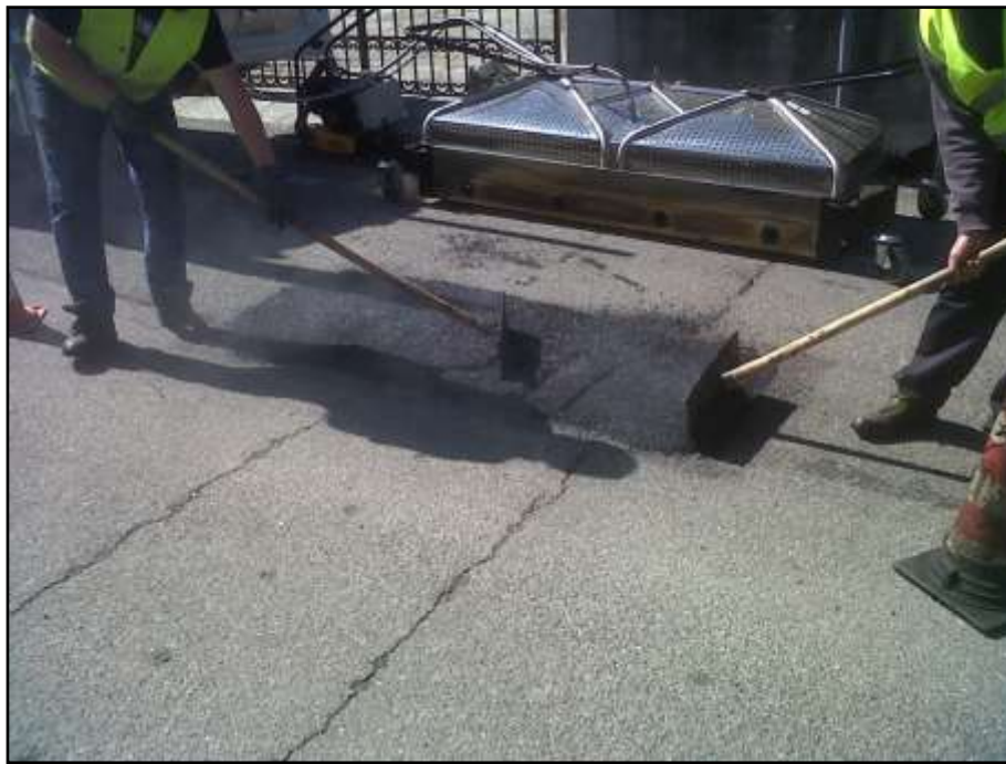
Lavorazione del materiale riscaldato e livellazione
