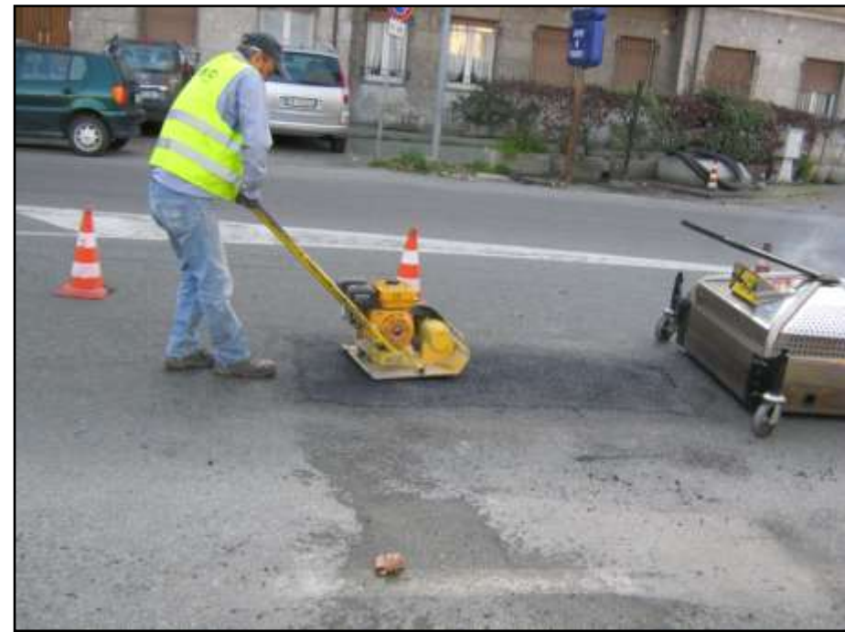
Compattazione della superficie
