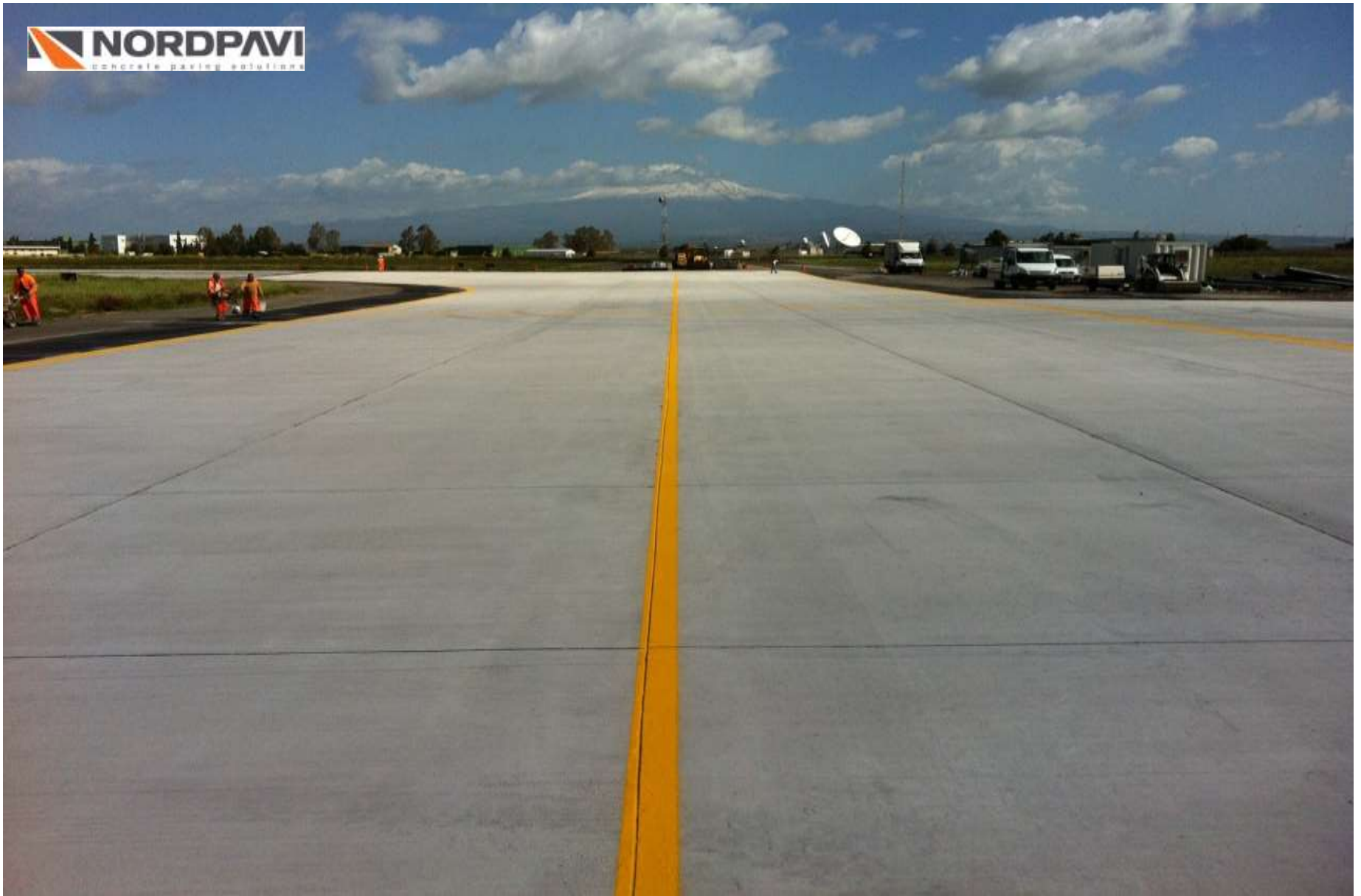
Aeroporto Sigonella - U.S. Navy (2013) 30.000 m 2 pavimentazione con trattamento antievaporante Sika Antisol S 19.000 m sigillatura giunti con Sikaflex PRO-3 SL
